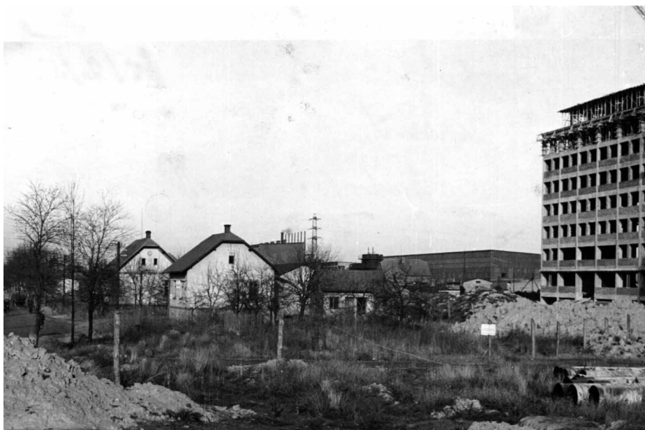
Výstavba správní budovy (říjen 1951)
