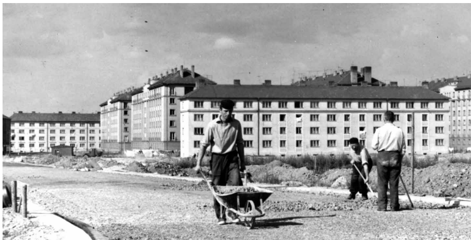
Staveniště v Zábřehu (31. 10. 1959)
