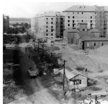
Výstavba nové Poruby (1953)
