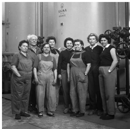
Energetika - BSP čistící stanice ve Vratimově (1961)
