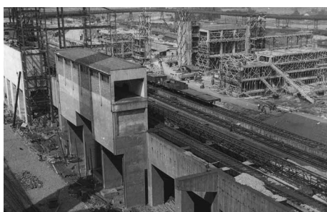
Pohled na rudný most (1952)
