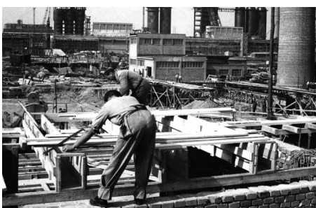
Tesařské práce na stavbě (24. 9. 1951)
