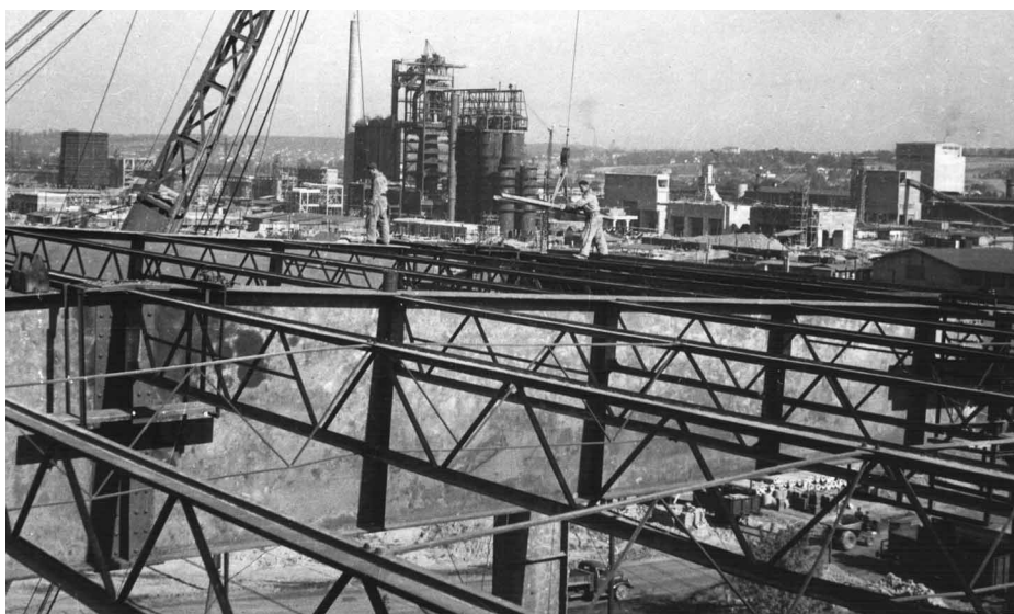
Montáž stropnic blokovny (30. 11. 1951)
